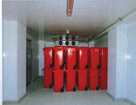
ห้องเย็นเก็บมูลฝอยติดเชื้อ แบบควบคุมอุณหภูมิไม่เกิน 10 องศาเซลเซียส
