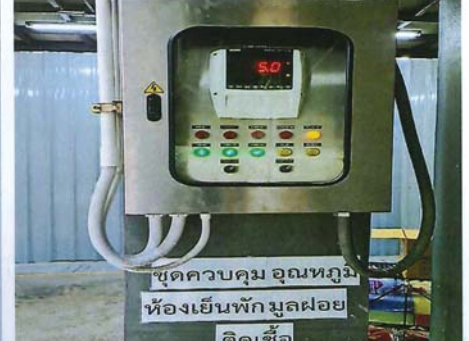
ห้องเย็นเก็บมูลฝอยติดเชื้อ แบบควบคุมอุณหภูมิไม่เกิน 10 องศาเซลเซียส
