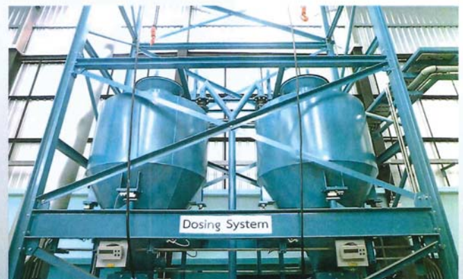
ชุดจ่ายสารบำบัด (Dosing) ซึ่งได้แก่ Sodium Bicarbonate Activated Carbon
